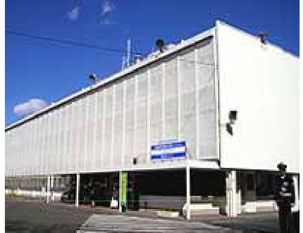
左の壁面に吊るされた36枚の光触媒シート
