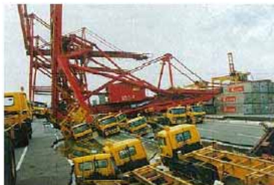
岸壁沈下と倒壊したクレーン
